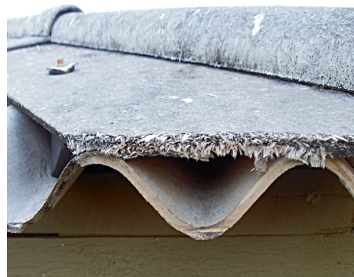
F246: Asbest, veel gebruikt als dakbedekking, wordt door weersinvloeden aangetast.
